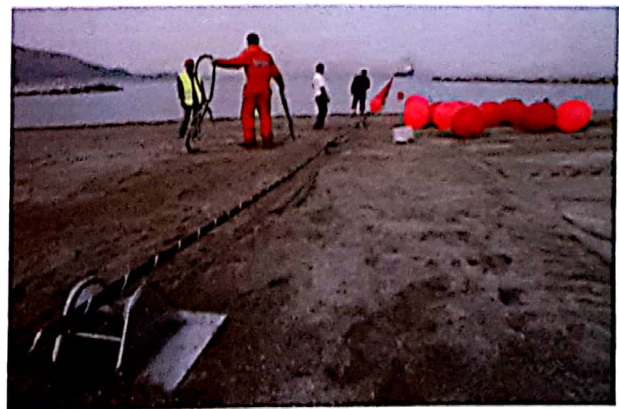
Doc. 18 Pose d'un câble sous-marin
