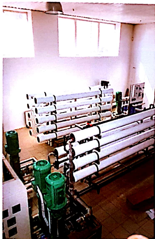
Doc. 9 Usine de dessalement : les tubes blancs contiennent les membranes, les moteurs verts actionnent les pompes hautes pressions
